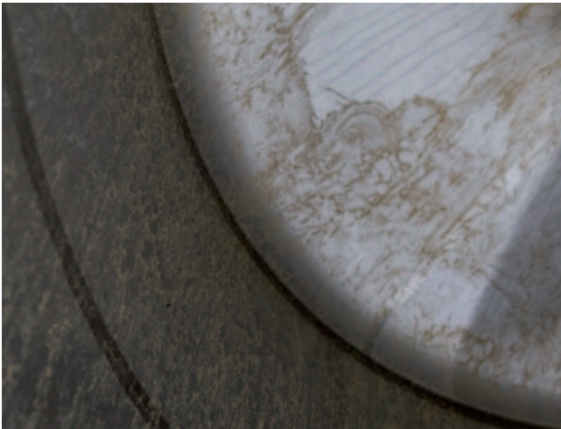
Verschmutzter Tank vor der Reinigung
